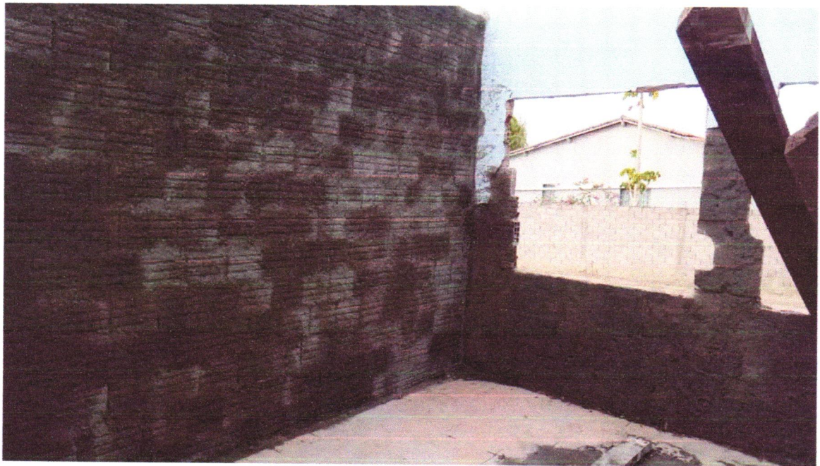
Foto 09 - CHAPISCO APLICADO EM ALVENARIA (COM PRESENÇA DE VÃOS) E ESTRUTURAS DE CONCRETO DE FACHADA, COM EQUIPAMENTO DE PROJEÇÃO. ARGAMASSA TRAÇO 1:3 COM PREPARO EM BETONEIRA 400 L. AF_06/2014
