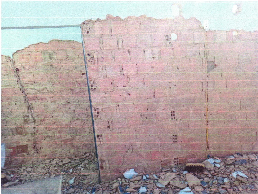
Foto 05- Demolição de reboco
