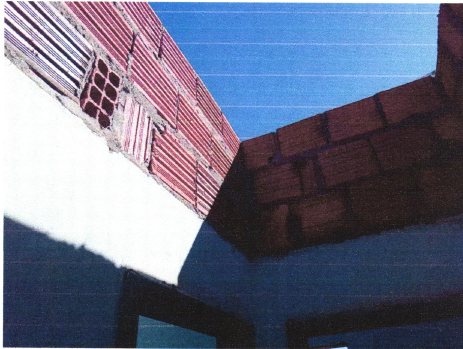
Foto 07 - ALVENARIA DE VEDAÇÃO DE BLOCOS CERÂMICOS FURADOS NA HORIZONTAL DE 9X19X29 CM (ESPESSURA 9 CM) E ARGAMASSA DE ASSENTAMENTO COM PREPARO EM BETONEIRA. AF_12/2021
