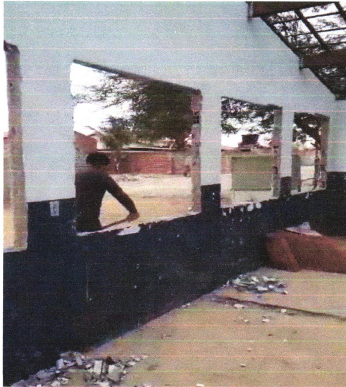
Foto 03 - Demolição de alvenaria de bloco cerâmico e=0,09m - revestida
