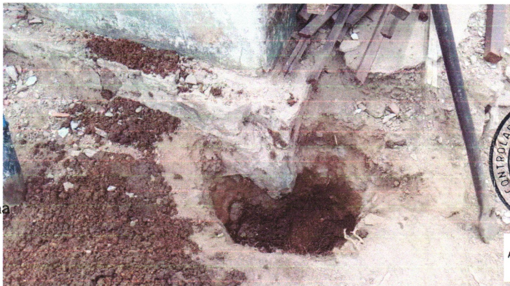
Foto 06 - ESCAVAÇÃO MANUAL DE VALA (INCLUINDO ESCAVAÇÃO PARA COLOCAÇÃO DE FÔRMAS). AF_06/2017
